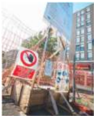
LAVORI Il cantiere M4 sta causando disagi in corso Indipendenza, corso Plebisciti e viale Argonne
